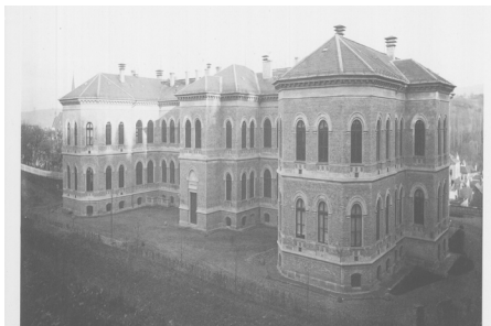
Fațada sudică a pavilionului de Anatomie (în 1900).
