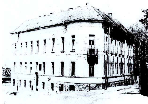
Clădirea B. Fosta sală de curs se află în latura din stânga sus.
